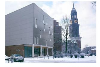
Das Abspannwerk Großneumarkt ist ein technisches Betriebsgebäude. Im Erdgeschoss befinden sich neben dem Gebäudezugang Ladenflächen. Die Fassade zum Großneumarkt aus dem Baujahr 1972 bestand aus Stahlbeton-Sandwich-Elementen mit Waschbeton-Oberflächen und horizontalen Aluminium-Fensterbändern; im Erdgeschoss befand sich eine Aluminium-Schaufenster-Fassade.
