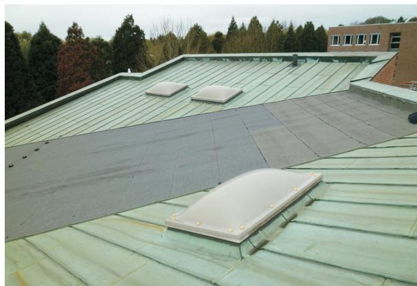
Im Rahmen der parallel durchgeführten, brandschutztechnischen Sicherheitssanierung des Biozentrums der Universität-Hamburg in Hamburg Klein-Flottbek war die vorhandenen, brennbare Innendämmung des großen Hörsaals zu entfernen. Da die bituminöse Abdichtung der dreidimensional verformten Dachfläche Schäden aufwies, sah das Instandsetzungskonzept von tlb architekten ingenieure eine energetische Sanierung nach EnEV 2009 mit Herstellung einer Außendämmung mit neuer Abdichtung vor.
